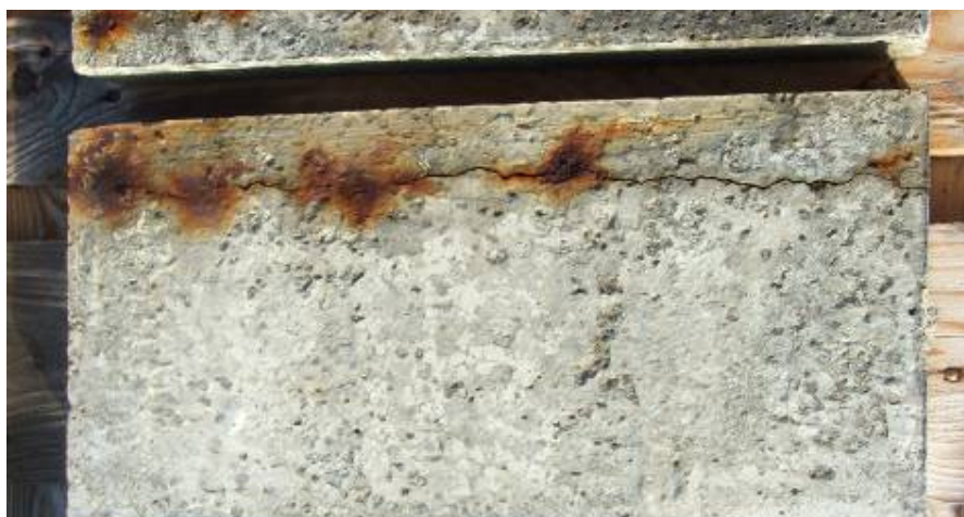
Figur 22 Betongblock med betongspricka orsakad av korrosionsprodukter från kraftigt korroderade provstänger av kolstål efter två års utomhusexponering. Inga sprickor från de rostfria provstängerna kunde konstateras.
