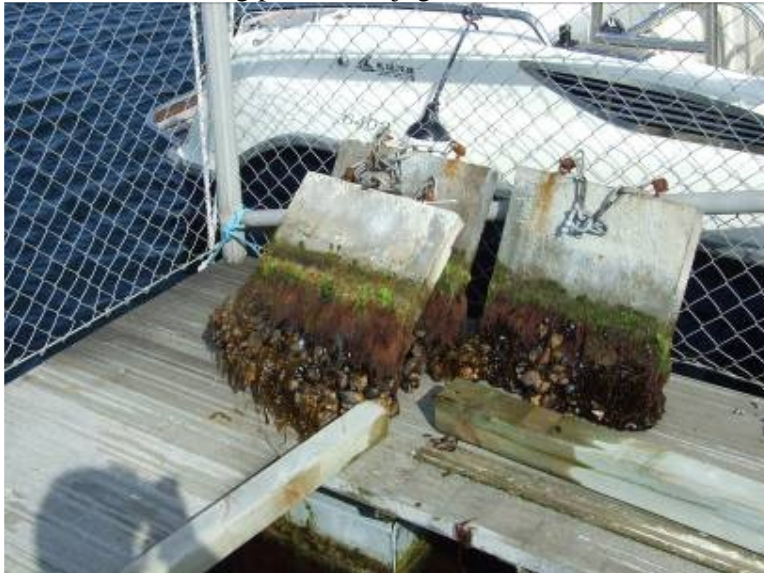
Figur 18 Utseendet av betongblock efter två års exponering i havsvatten.
